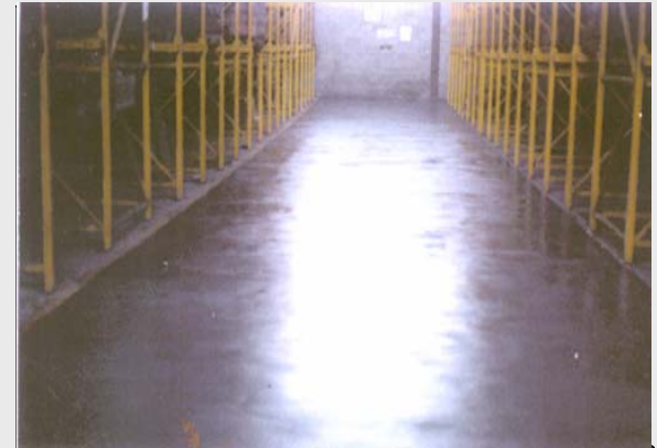
Sistema Stone Floor , aplicado en bodega de Korn Products de Mexico, S.A. de C.V. (Productos de Maíz) 1,200.00 M2. México D.F. Año 1985
