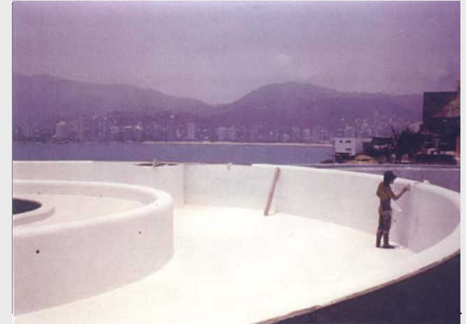
Top finish 99 aplicado en azotea Casa habitacion. Acapulco, Guerrero.1,890.00 M2. Año 1993
