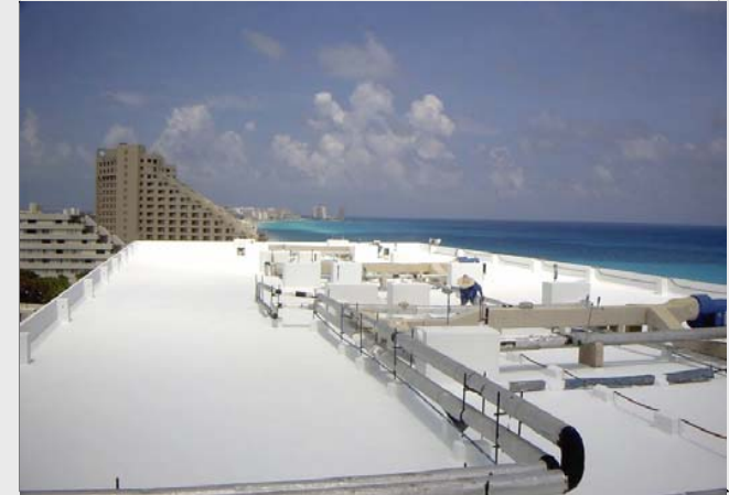
Sistema Imper Slim 80 , aplicado en Sheraton Cancun Resort and Hotels, Edificio Resort . 2,036.66 M2. Cancún Q.R. Año 2002
