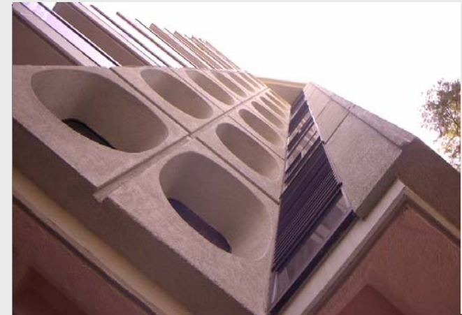
Acri Slim 96 , aplicada en fachada y diversas areas en Edificio de Departamentos ubicado en Av. Rio Churubusco. Col. Florida. 2,800.00 M2. Mexico D.F. 2002
